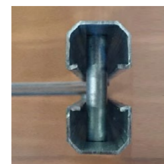
Sezione montanti Securtrio
